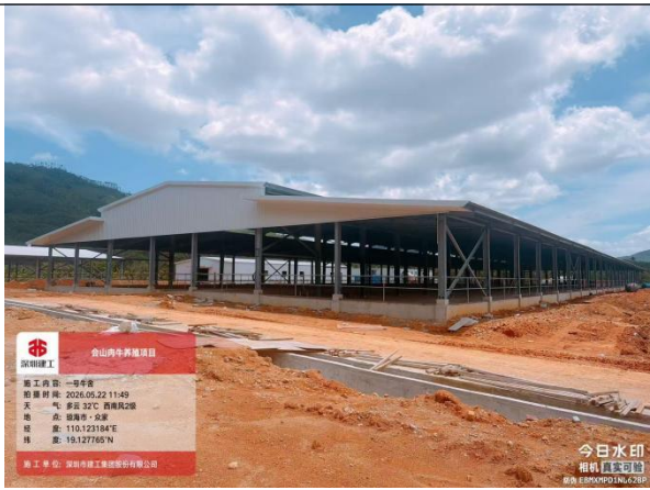
1#牛舍施工现状
