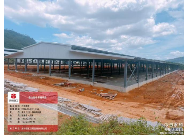
2#牛舍施工现状
