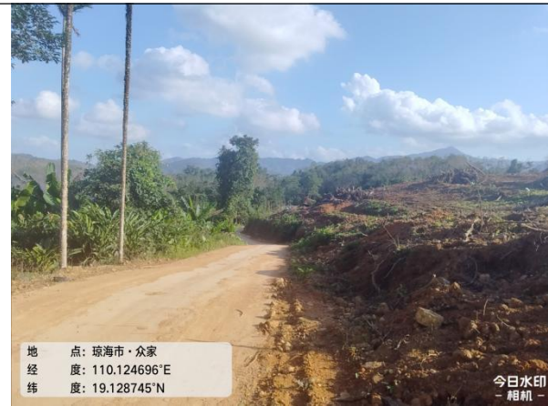
施工进出道路
