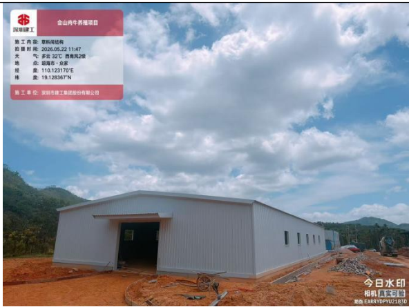
草料储存间施工现状
