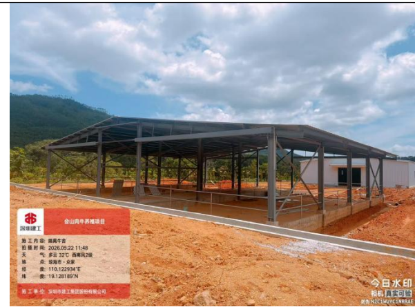
隔离牛舍施工现状
