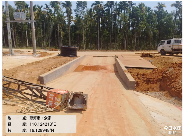
洗车池、沉沙池现状
