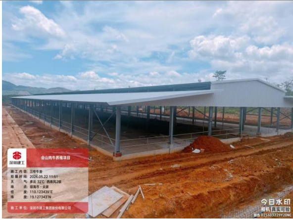
3#牛舍施工现状
